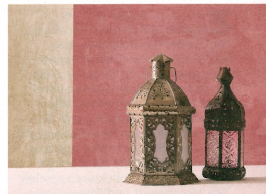
Mit Kalkfeinputzen lassen sich hochdichte, marmorierte Oberflächen schaffen
