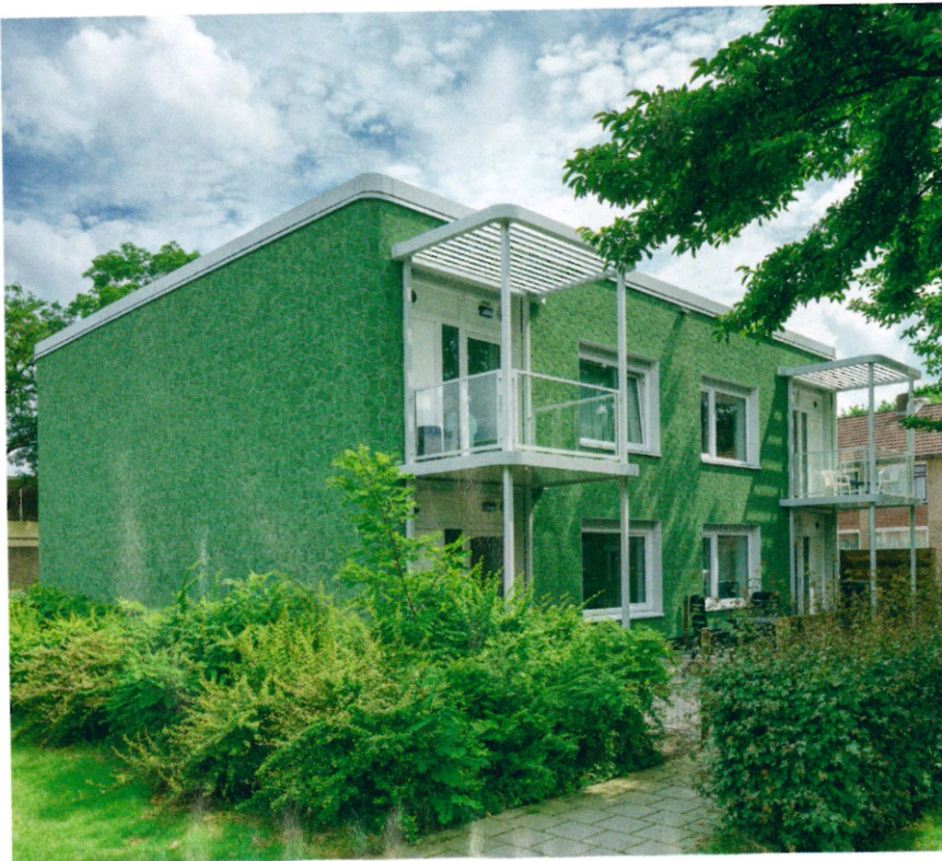
Fassade aus vorgefertigten Putzelementen: Darunter liegt der neue Wärmeschutz. Ronald Tilleman, Rotterdam, NL/Sto SE & Co. KGaA
