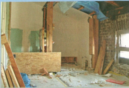
Kaum vorstellbar, dass hier ein ambientereiches Refugium entstehen wird. Aber unser Bauherr wusste, was er tat: Entkernung bzw. Öffnung war Schritt Nummer 1.
