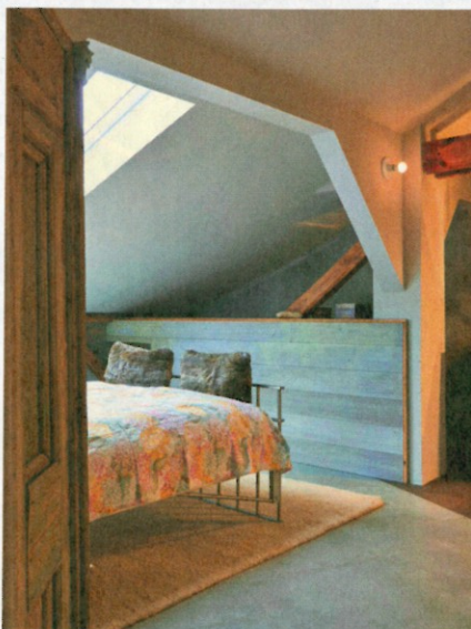
Hier noch die Gegenperspektive mit halbhoher Trennwandverkleidung. Hier wurden speziell gefräste Dielen aus Thermo-Buche verwendet, die weiß geölt sind und so zum Grau des Bodens passen.
