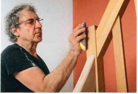
Treppe renovieren Schleifen, ölen, polieren
